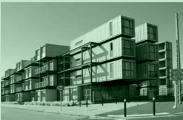
Voorbeeld containerwoningen: bouwkosten van € 1.000 tot € 1.600 per m2
